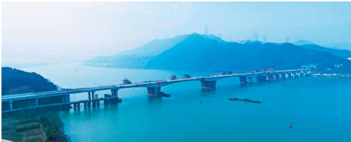
12月25日，富春江特大桥双向贯通（市交通运输局提供）
