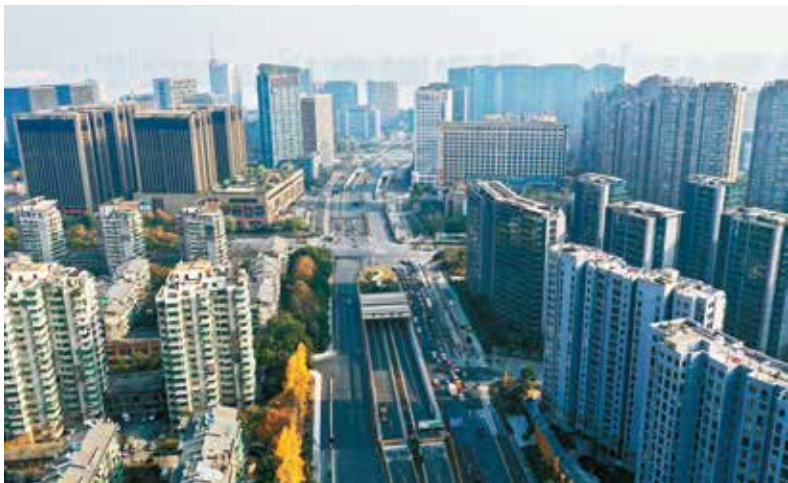
12月15日，望江隧道分阶段开通试运行。 图为望江隧道俯瞰
