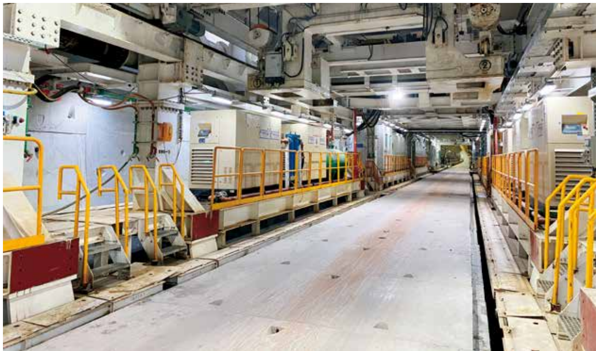
3月14日，杭州博奥隧道“亚运号”盾构机始发。图为博奥隧道内景（市钱江新城管委会提供）
