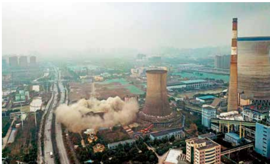
1月13日,杭州华电半山发电有限公司内的5号冷却塔被机械切割拆除
