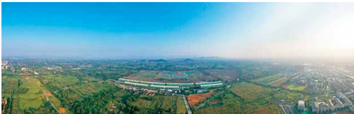
9月17日，杭州西站枢纽暨湖杭铁路工程在余杭区仓前街道老宣杭线仓前物流基地北侧区块开工
