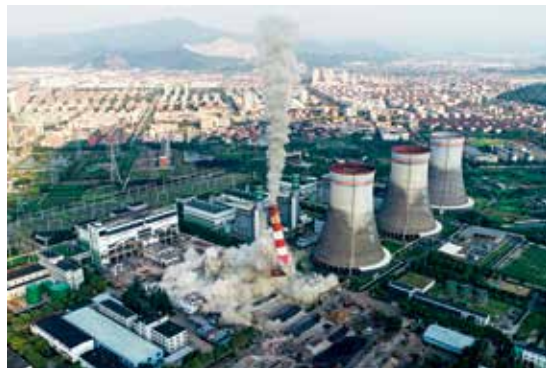
萧山发电厂（临浦电厂）内高达 180 米的大烟囱爆破拆除
