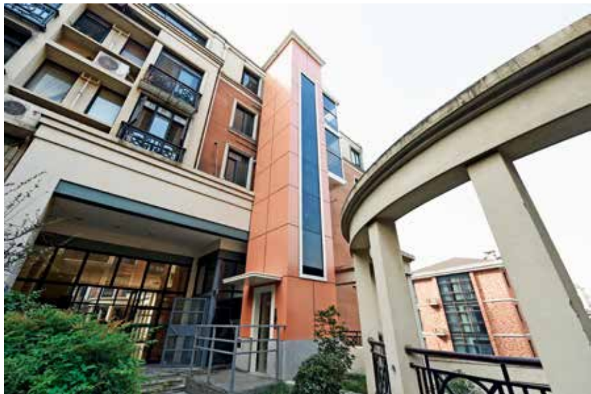
10月30日，杭州首台空中加装电梯在上城区清波苑小区交付使用
