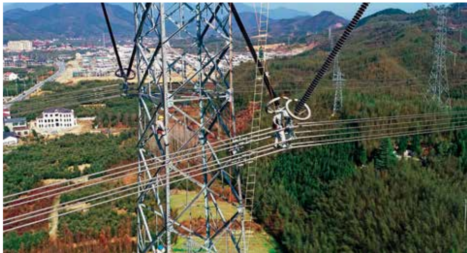
11月29日，国家电网浙江电力杭州（红船）共产党员服务队的10名队员在临安於潜山地一座高达80米的特高压电力铁塔上完成该公司历史上首次直流±800千伏特高压带电作业
