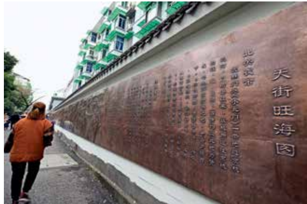
46 米的铜质浮雕《天街旺海图》在下城区胭脂新村社区天水巷西口围墙上安装完成
