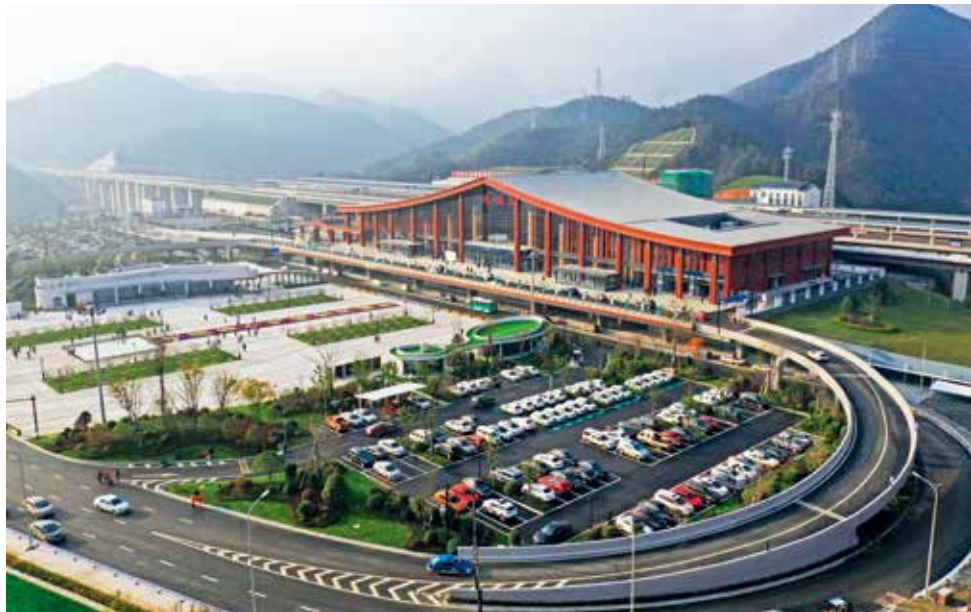
杭黄高铁建德站
