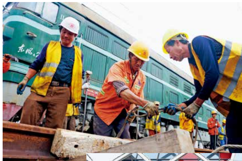
5月1日，在杭黄铁路浙江段桐庐站施工现场，600多名建设者放弃五一假期休息，坚守各自岗位，全力推进铁路站房建设及配套设施施工
