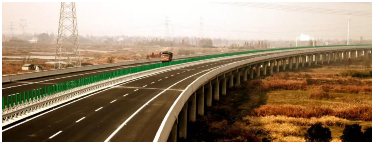
2012年杭长高速公路余杭高架桥段建成通车
