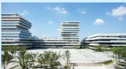
9月25日, 杭州国际城市学研究中心(浙江省城市治理研究中心)被列为首批浙江省新型重点专业智库
