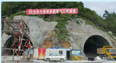
9月6日上午，千黄高速05标亚山2号隧道右洞顺利贯通（隧道左洞仍在施工中）
