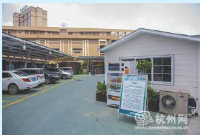
8月8日,全国首座电动汽车充电站微综合体在杭州正式对外亮相
