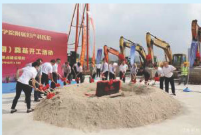
8月16日,浙江大学医学院附属妇产科医院新院区——钱江院区项目(一期)在钱江世纪城奠基动工
