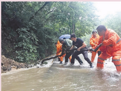
6月19日傍晚，西湖风景名胜区巡逻队发现虎跑路积水，市政部门第一时间赶往现场排障疏通
