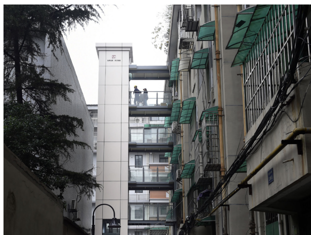
11月15日，杭州2017年首个既有住宅楼加装电梯项目——上城区清波街道新民村2幢1单元的加装电梯已基本安装就位，28日投入试运行（杭州图库 提供）
