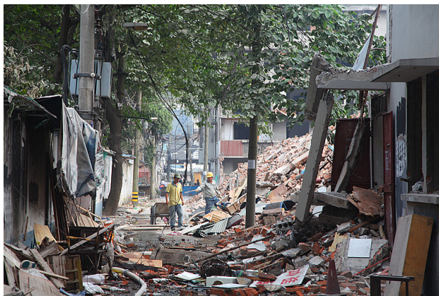
百井坊地块在拆除中
