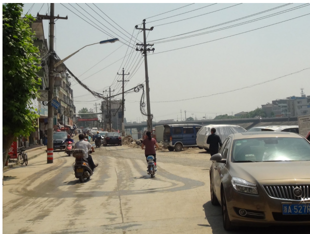
外窑街原沿河搭建的商铺房已拆除
