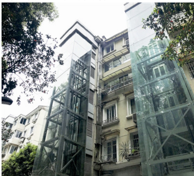
西湖区灵隐街道东山弄社区里的两幢居民楼多年前就已经安装了外挂式电梯（李忠 摄）
