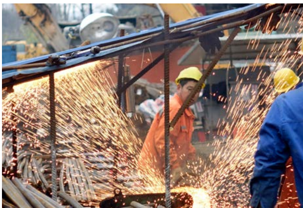
2月1日，在杭州地铁2号线武林门站工地里，施工人员正忙着焊接钢筋梁架（杭州图库提供）
