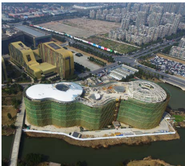
2月19日，正在安装双曲面铝板弧形屋顶的中国动漫博物馆（杭州图库提供）
