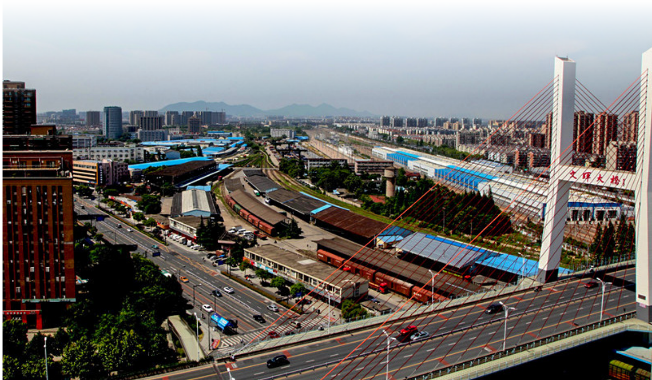
文晖大桥下的艮山门站
