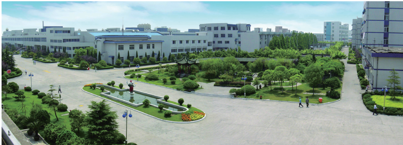
杭州娃哈哈集团有限公司下沙基地厂区
