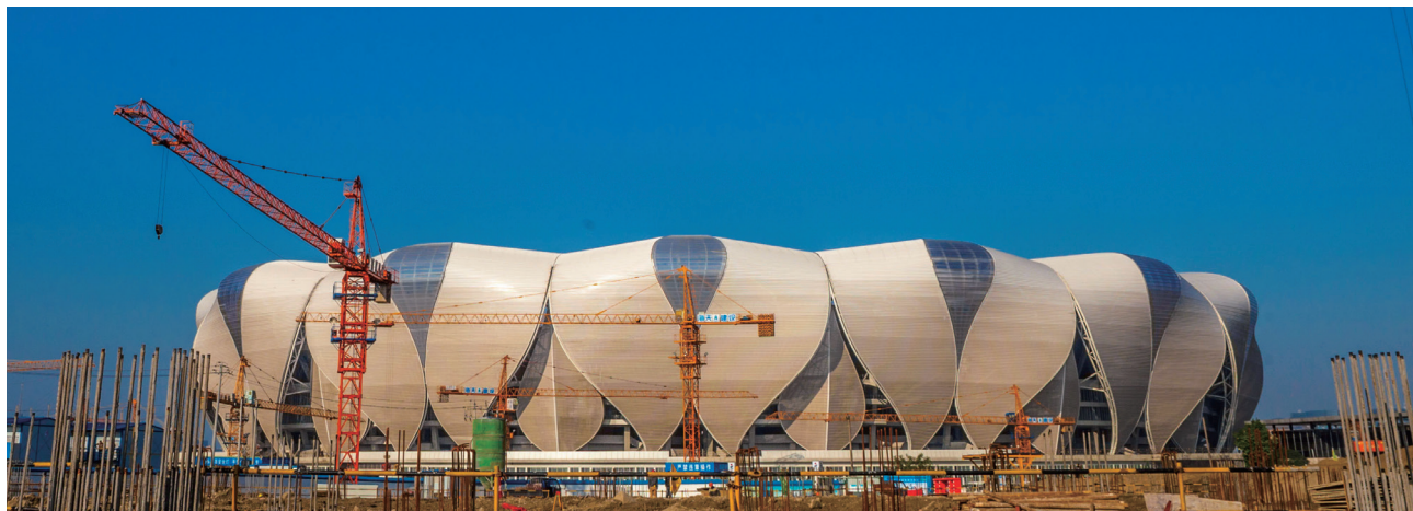
建设中的2022年第19届亚运会主场馆
