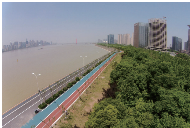
位于钱塘江南岸的杭州首条沿江超长彩色跑道
